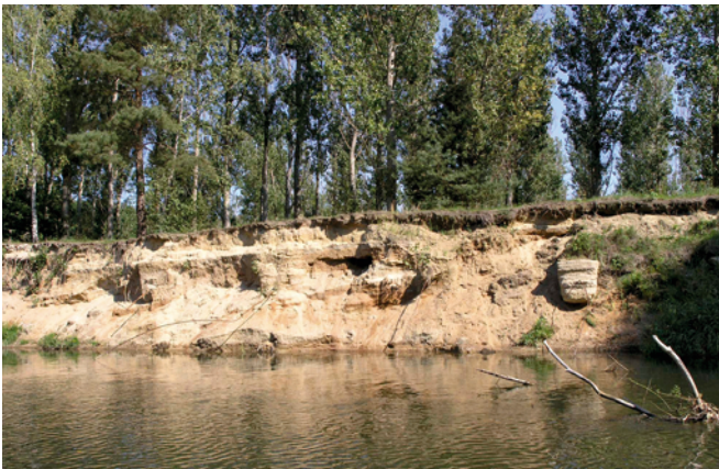
Abb. 29: Abbru- chufer an einem Prallhang der Neiße. Foto: Archiv LfULG, H. Blischke
